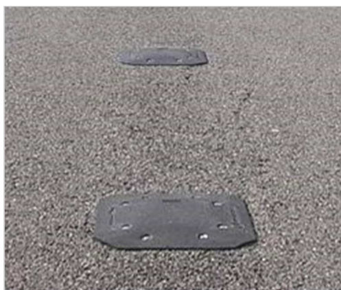
Figura 5 Specifiche tecniche e posizionamento "raddoppiato" dei contatori/analizzatori su strada a 2 corsie, 1 per senso di marcia (4 NC-97)
